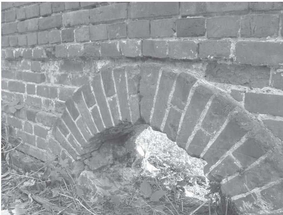
Рис.6 Дренажное отверстие северной стены.
