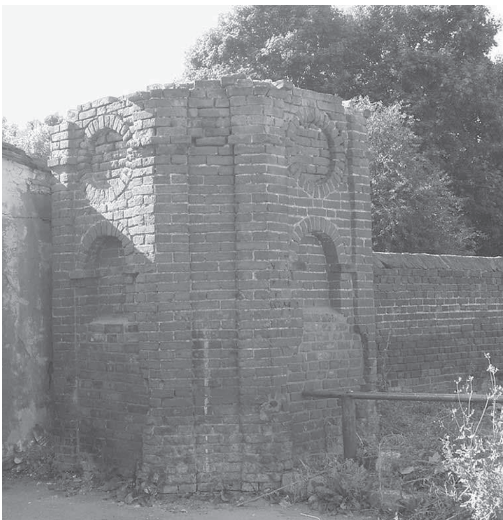
Рис.8 Внешний вид северо-восточной башни.
