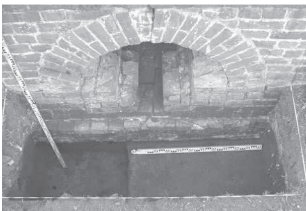
Рис.7 Дренажное отверстие после расчистки и чертеж поперечного сечения каменной ограды.
